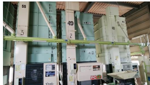
収穫調整施設調査
